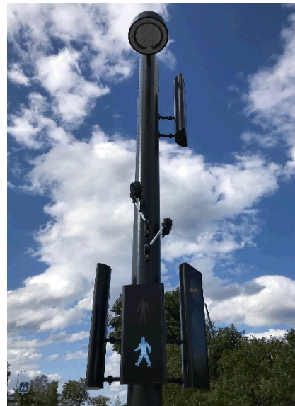
De gamle master i signalanlægget ved Søndre Havnevej er blevet udskiftet.
