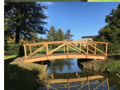
Øverst: Den nordlige bro. Nederst: Den sydlige bro under monteringen.
