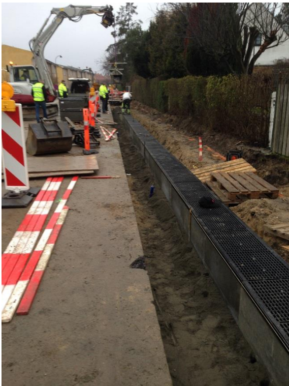
Sætning af vandrender på Mosegårdsvej.
