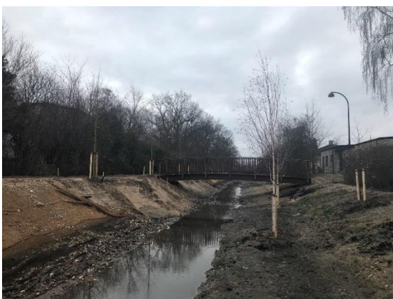
Nye træer og ny gangbro.
