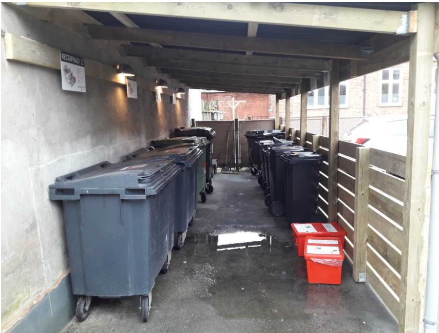
Eksempel på etablering af nyt overdække til affaldshåndtering og optimering af p-forhold på mindre ejendom (januar 2020).
